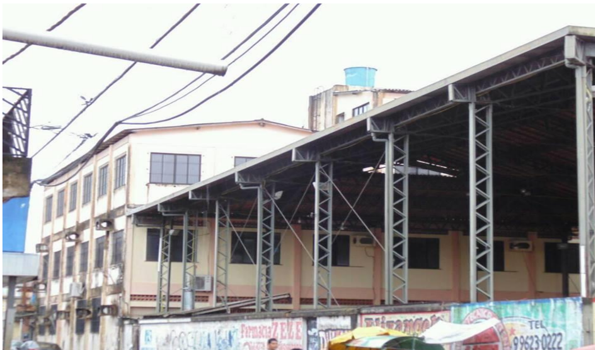
Foto 5 - Anexo da Paróquia São Domingos de Gusmão
