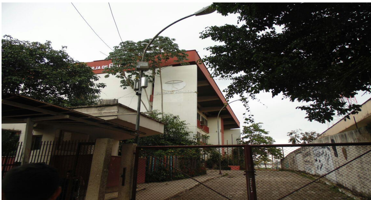
Foto 10 - Prédio onde funciona a Escola Dr. Celso Malcher
